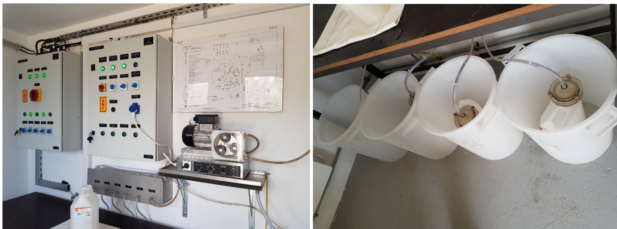
Slika 1.2: Avtomatska vzorčevalna postaja HE Brežice (7,2 km nizvodno od NEK), kjer poteka kontinuirni zajem vzorcev vode
