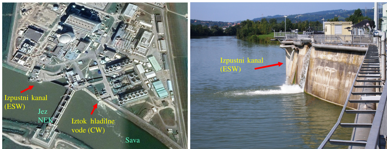
Slika 1.1: Izhod bistvene oskrbne vode (ESW), kjer se izpuščajo radioaktivne tekočine iz odpadnih merilnih rezervoarjev (WMT) in sistema za kaluženje uparjalnikov (SGBD). Fotografija na desni je posneta z jezua NEK.
