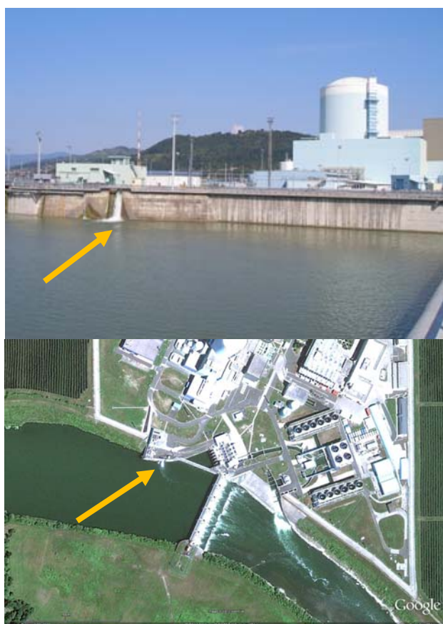
Slika 2.1: Izhod bistvene oskrbne vode (ESW), kjer se izpuščajo radioaktivne tekočine iz odpadnih merilnih rezervoarjev (WMT) in sistema za kaluženje uparjalnikov (SGBD)
