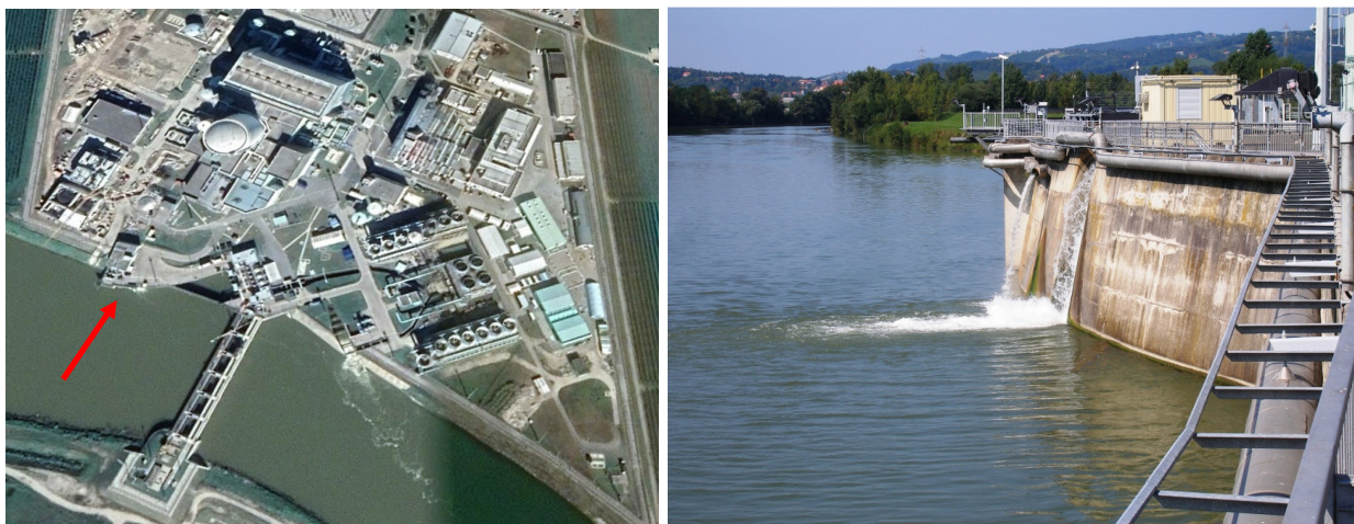
Slika 1.1: Izhod bistvene oskrbne vode (ESW), kjer se izpuščajo radioaktivne tekočine iz odpadnih merilnih rezervoarjev (WMT) in sistema za kaluženje uparjalnikov (SGBD).). Fotografija na desni je posneta z jezga.
